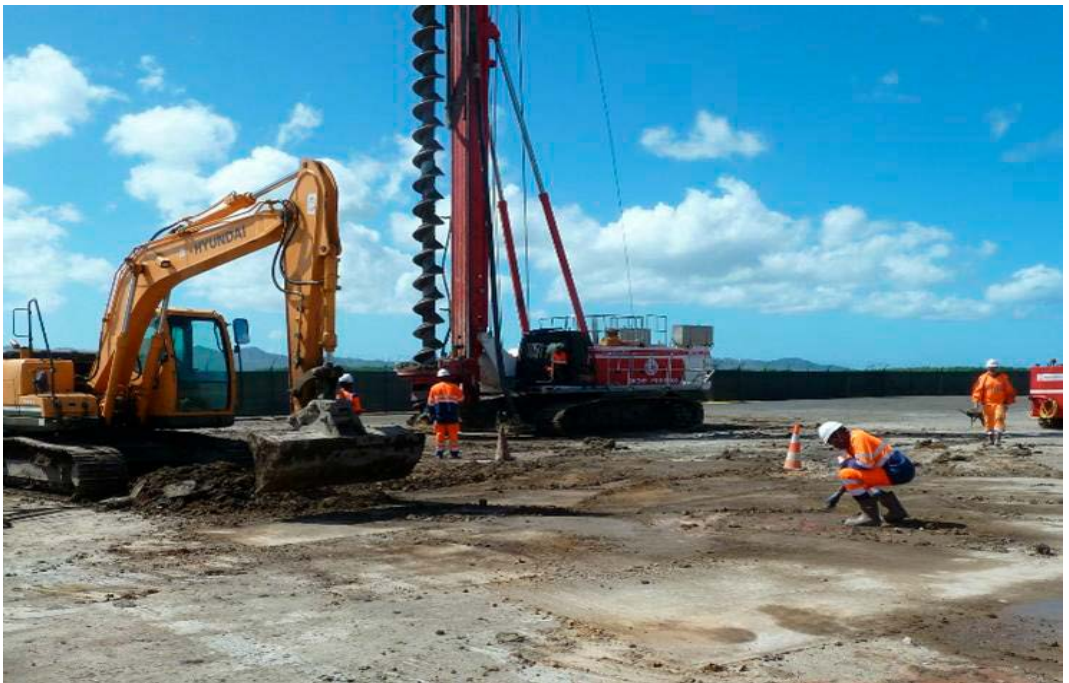
Travaux d'extension de l'aéroport Aimé Césaire (photo : SAMAC)
