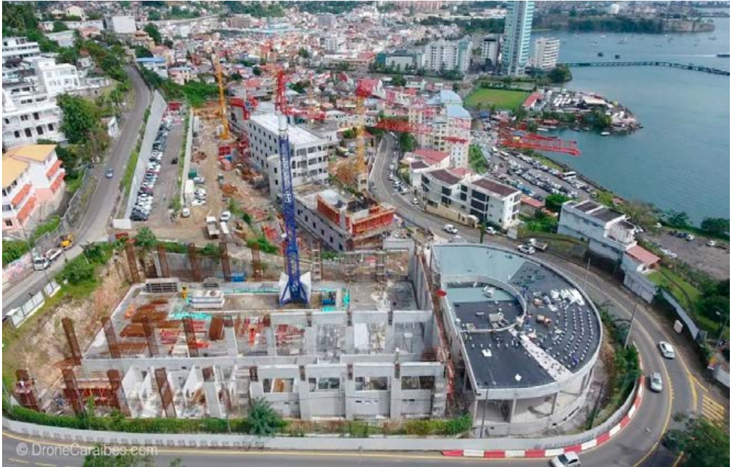
Chantier lycée Schoelcher (photo : SIMP)
